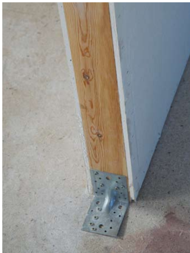
Die Innenwände der standardisierten Häuser sind beidseitig mit Gipskartonplatten beplankt.
