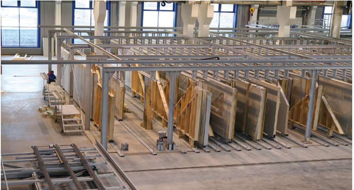
Im Wandlager kann der Putz zwei Tage lang trocknen, bevor die Elemente auf die Baustelle gehen.
