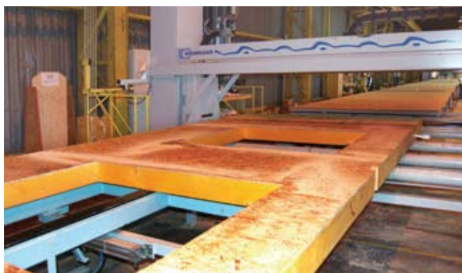
Beplankte Wandelemente mit Ausschnitten, die mit Multifunktionsbrücke ausgefräst werden.
